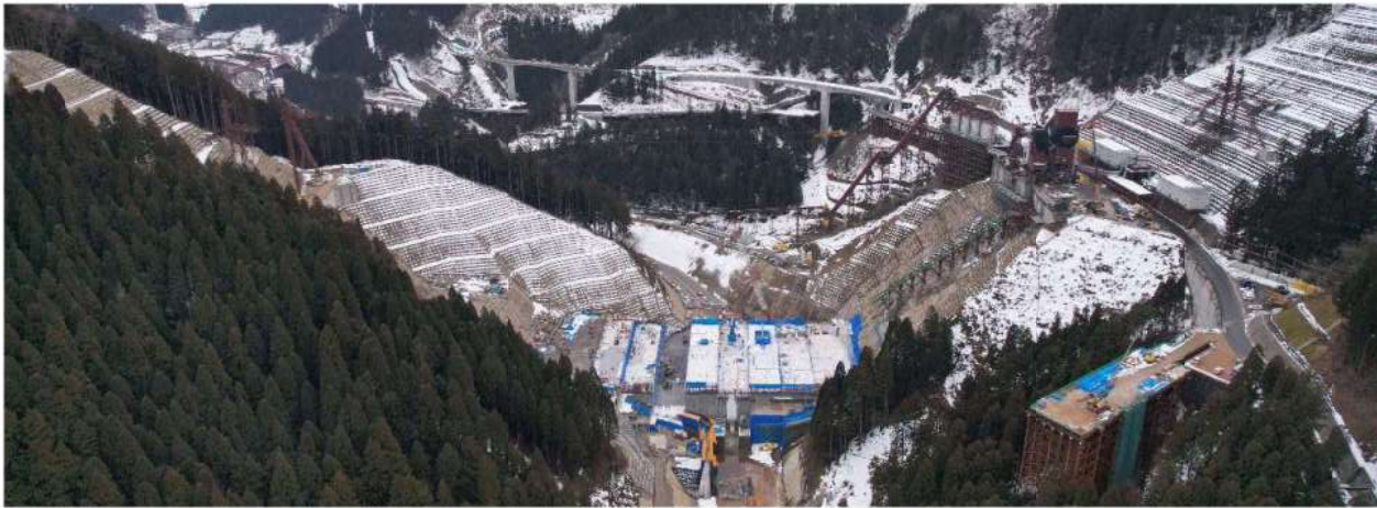
[4]足羽川ダム本体建設(第1期)工事
