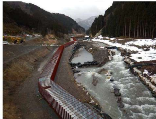
[9]足羽川ダム水海川貯砂ダム工事
