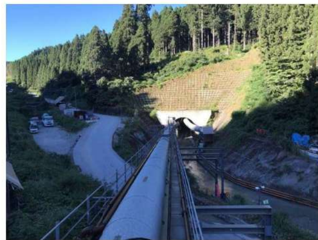
[6]水海川導水トンネル2期工事
