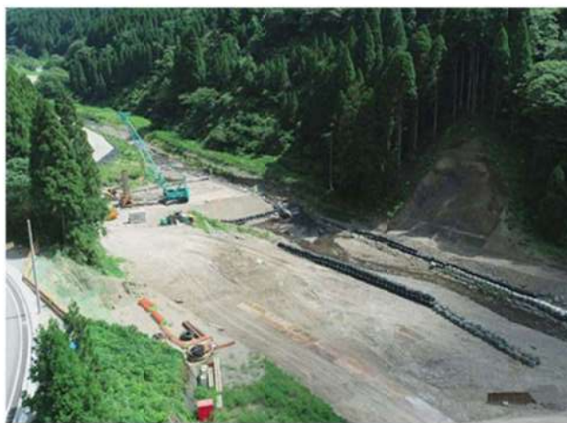
[9]足羽川ダム水海川貯砂ダム工事
