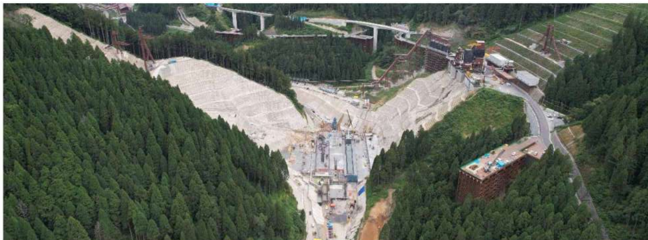
[4]足羽川ダム本体建設(第1期)工事
