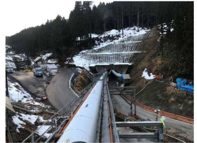
[6]水海川導水トンネル2期工事
