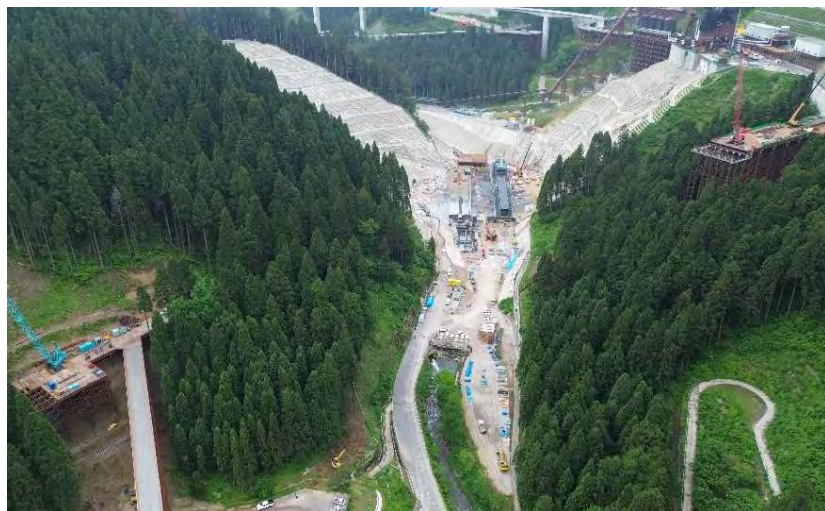
付替県道4号橋
