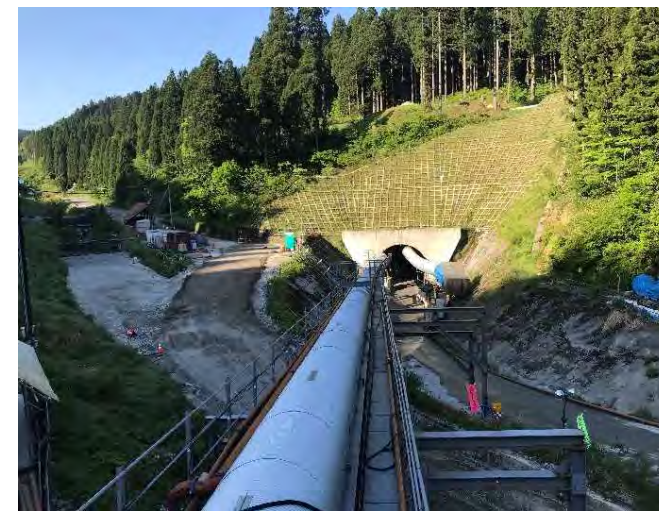
水海川導水トンネル
