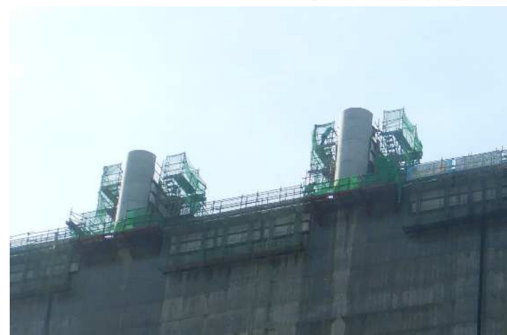
プレキャスト型枠のイメージ
