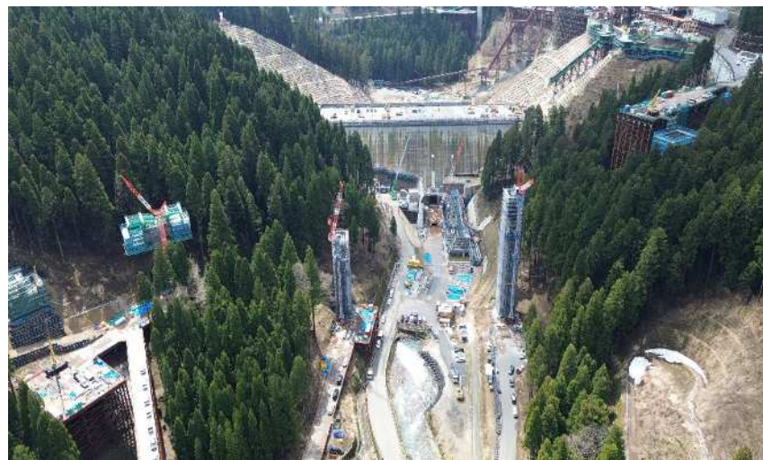
足羽川ダム付替県道4号橋他工事
