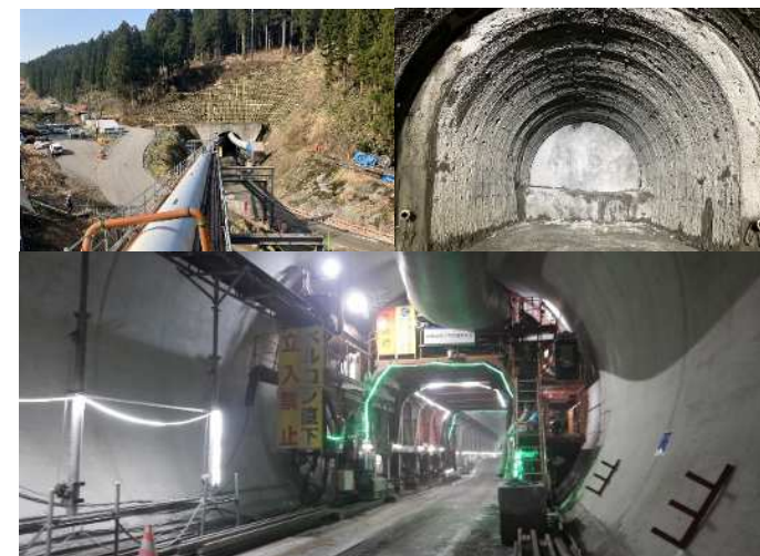
水海川導水トンネル3期工事
