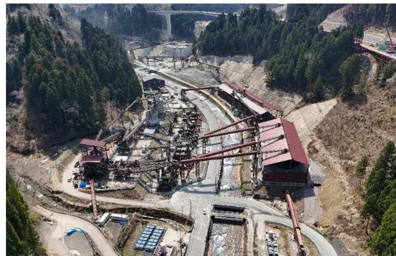
足羽川ダム本体建設(第2期)工事 (骨材製造設備)
