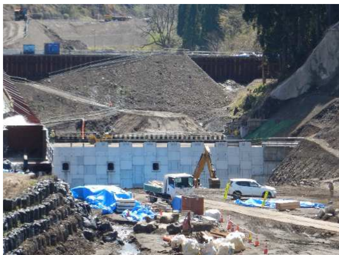
足羽川ダム水海川貯砂ダム工事
