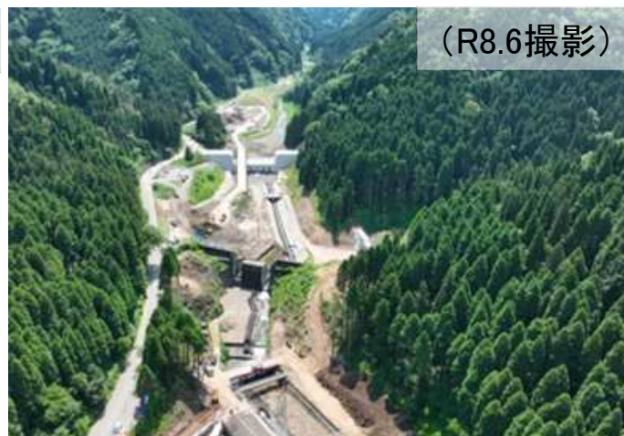
足羽川ダム水海川分水堰工事
