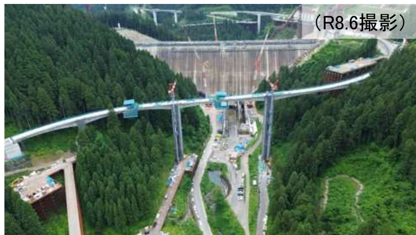
足羽川ダム付替県道4号橋他工事
