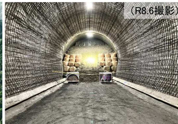
水海川導水トンネル3期工事
