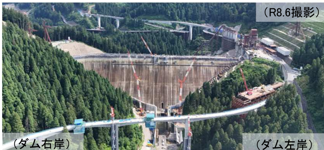
足羽川ダム本体建設(第2期)工事
