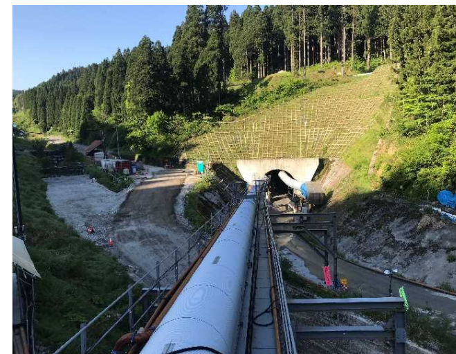
水海川導水トンネル
