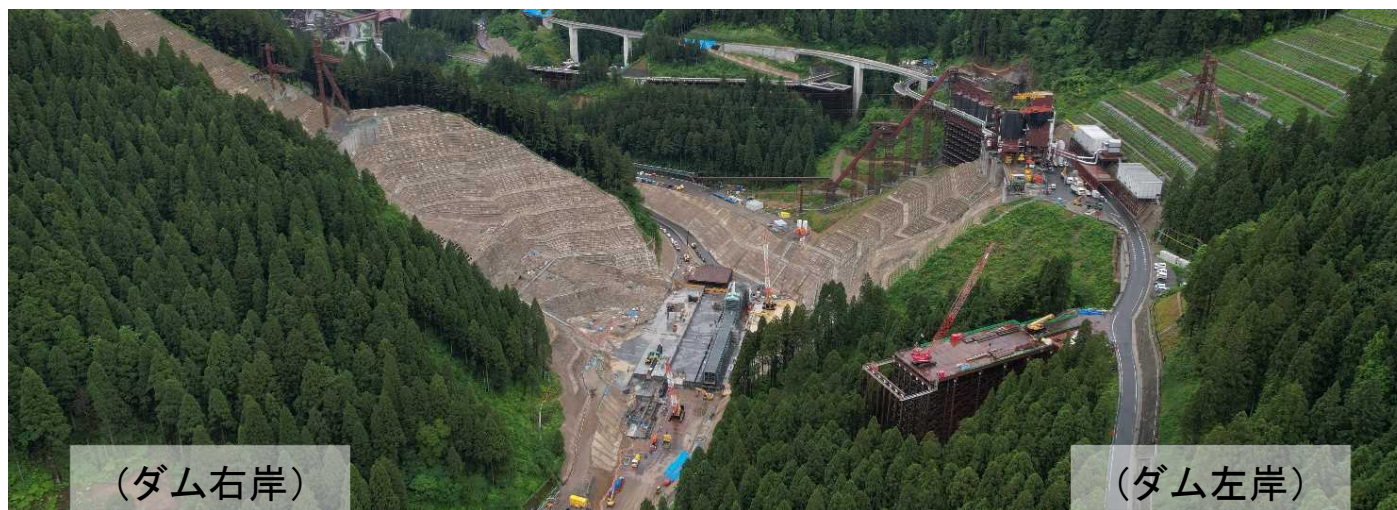
ダム本体(下流から上流を望む)
