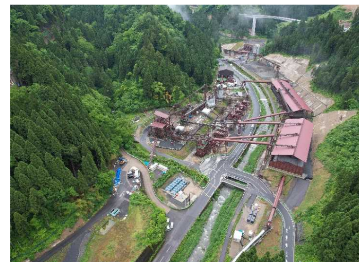
(骨材製造設備)
