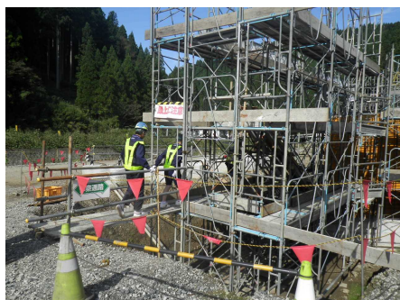
■足羽川ダム（宮の谷川函渠工事現場）
