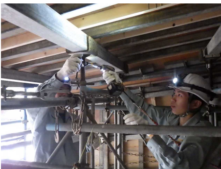
■体験学習 （型枠支保工）
