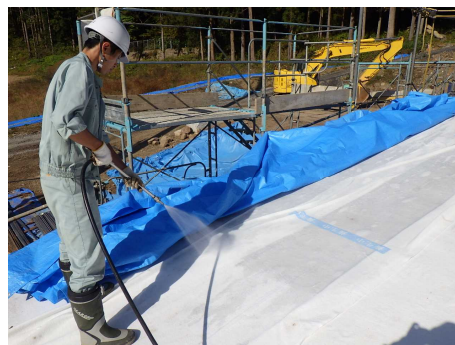
■体験学習 （コンクリート養生）
