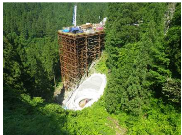
【付替県道7号橋工事現場】
