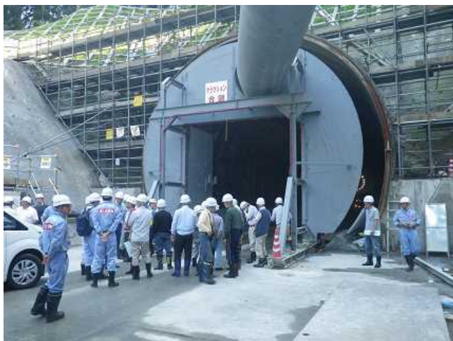
【導水トンネル工事現場】
