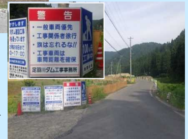
交通安全対策の事例→ (徐行看板の設置)
