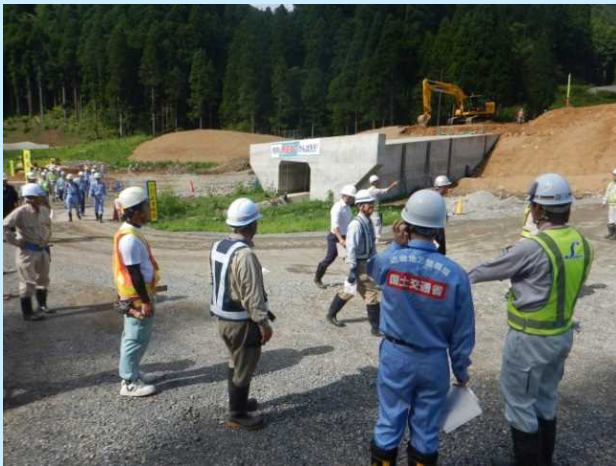
付替県道工事の点検状況
