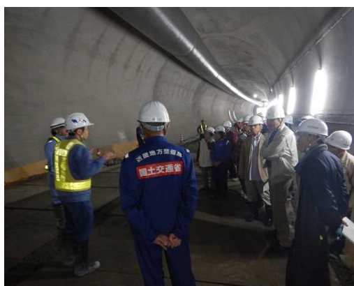
【導水トンネル工事現場】
