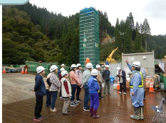
【付替県道8号橋工事現場】
