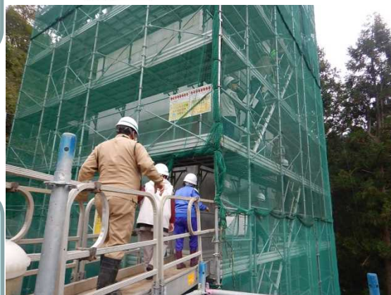
【付替県道8号橋工事現場】
