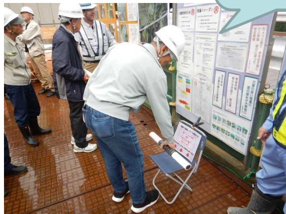
【付替県道8号橋工事現場】
