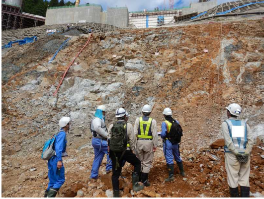
地質調査実施状況
