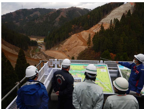
ダム本体の掘削状況確認
