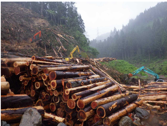
伐採施工状況(堤体右岸)
