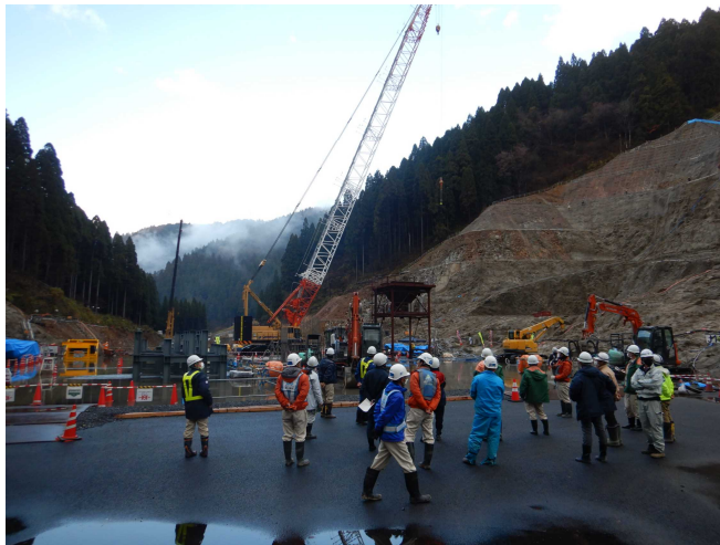
ダム本体のコンクリート打設状況確認
