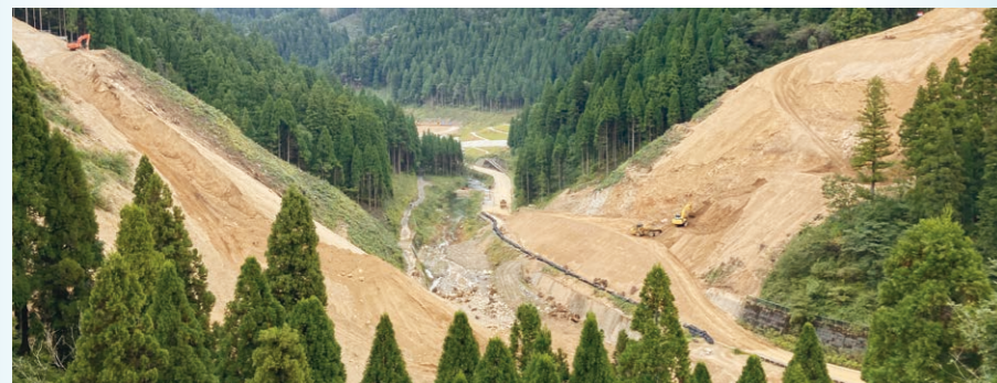
ダム本体工事 (令和3年10月時点)
