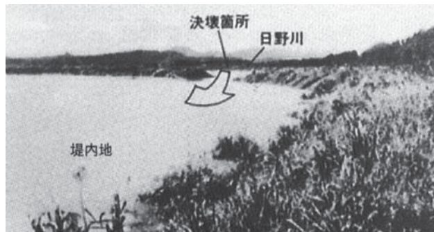
昭和28年9月洪水（台風13号） 福井市三郎丸付近（日野川が破堤）
