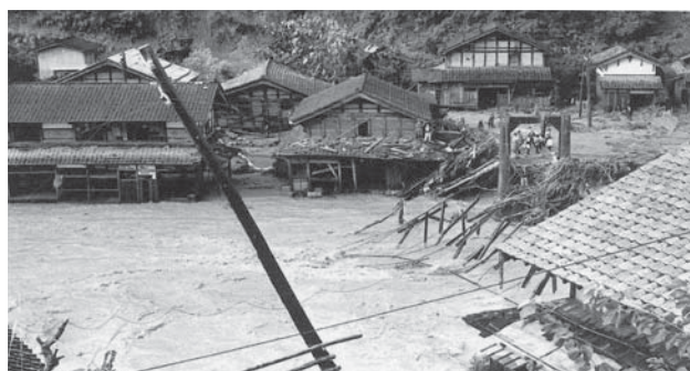
昭和40年9月洪水（奥越豪雨） 西谷村（現大野市）の被災状況
