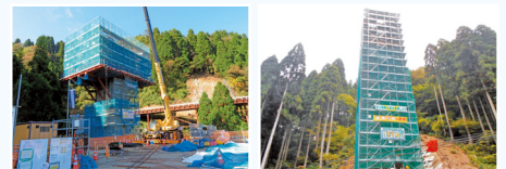
付替県道7号橋と11号橋の工事の様子
