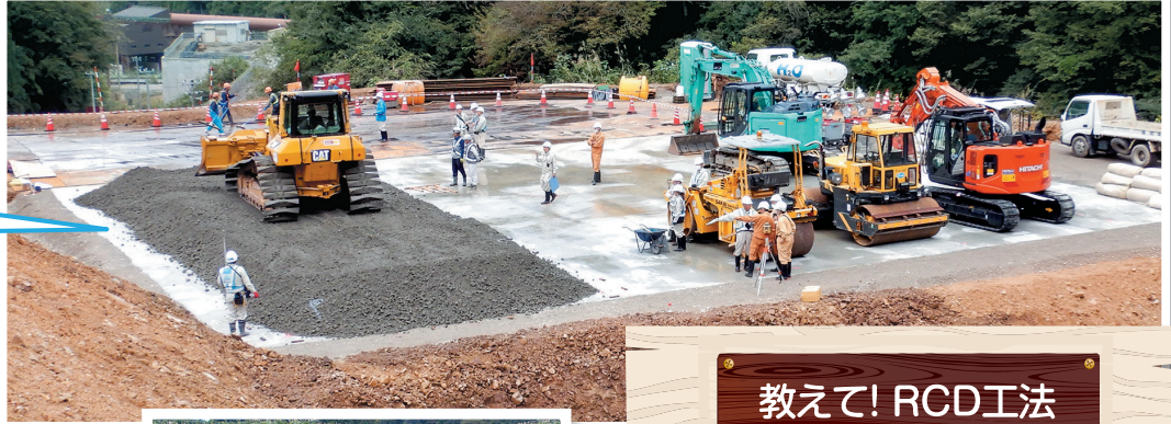
実際に打設されるダムのコンクリート
