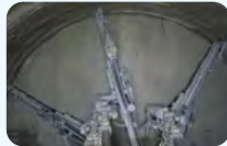
▲ ロックボルト設置
