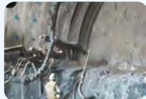
▲ コンクリート吹き付け
