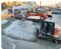
▲ 締め固めの重機（バイバック）
