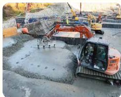
▲ 締め固めの重機（バイバック）
