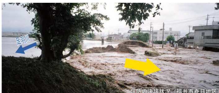
堤防の決壊状況(福井市春日地区)
