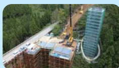
付替県道（橋梁）工事
