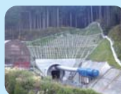
導水トンネル工事
