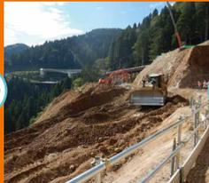
固い岩盤までの掘削と水漏れ防止工事を行います。
