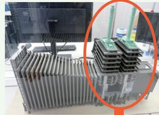
河床部放流設備のゲート(主・副)を取り付けます。
