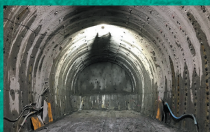
トンネルの先端部 (切羽)
