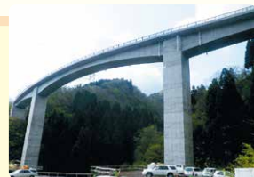
▲ 完成した8号橋
