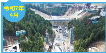
P1橋脚から、道路となる橋桁をつくる「張出架設工法」に着工
