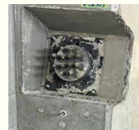
緊張を終え、切断されたPC鋼線。
