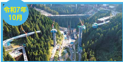
4つある橋脚の外側(P1、P4)から張出架設工事が進捗
