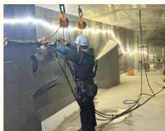
橋桁の中。鋼線とジャッキをつなぐ準備中。
