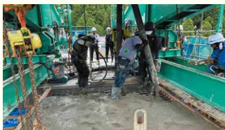
P2橋脚とP3橋脚をつなぐ、最後のコンクリート打設を行いました。
