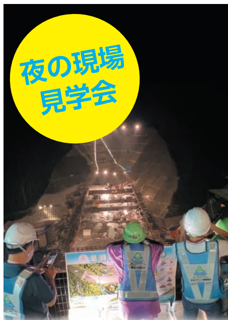
ダム左岸天端からのようす
