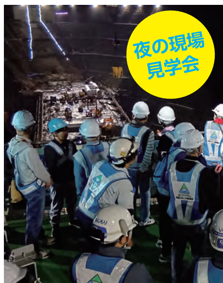
ダム左岸天端からのようす
