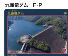
配布場所: 九頭竜ダム管理支所 福井県大野市長野第33号4番地の1
