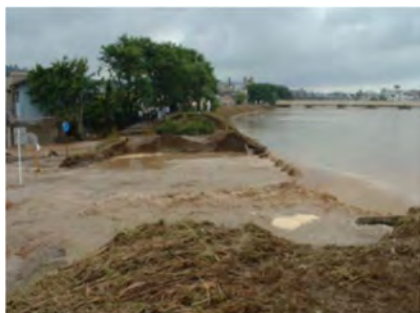
足羽川流域(福井市春日付近：堤防の決壊) 平成16年7月福井豪雨
