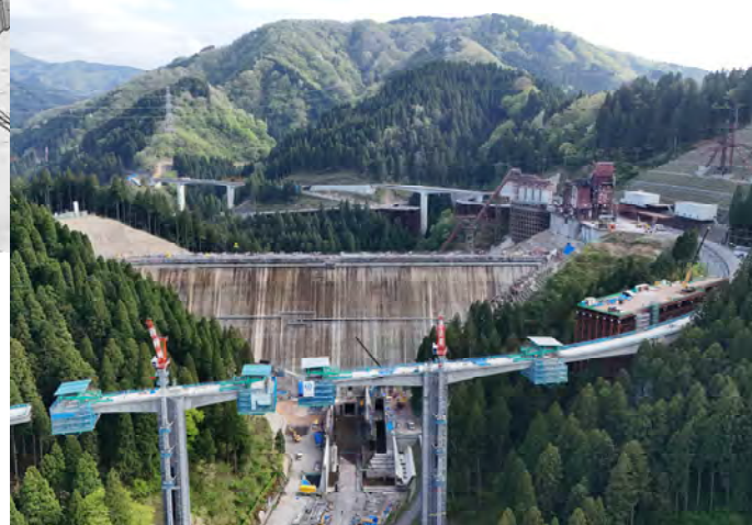
ダム堤体施工状況(令和8年4月)
