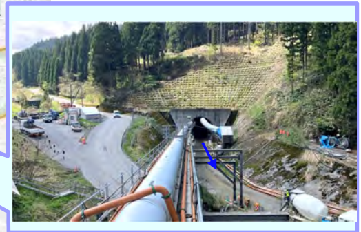
■ 導水トンネル吐口(令和8年4月)
