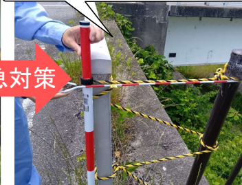
転落防止柵の間隔が広く 通り抜けの可能性あり
