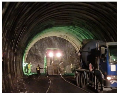
■ 導流部 平成 27 年 1 月撮影
