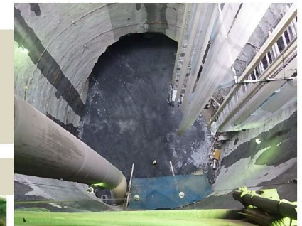
■ ゲート室部立坑 平成 27 年 1 月撮影
