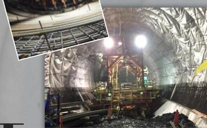
トンネル内部を鉄筋コンクリートで
