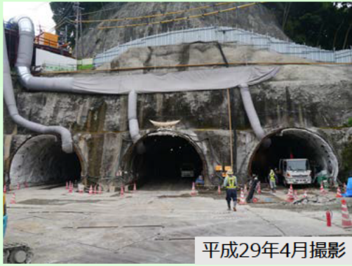
側壁導坑・中央導坑掘削
