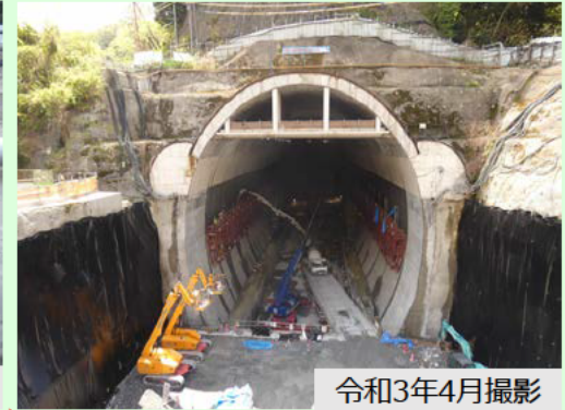
側壁コンクリート打設
