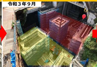
本体A・Cの頂版コンクリート打設完了
