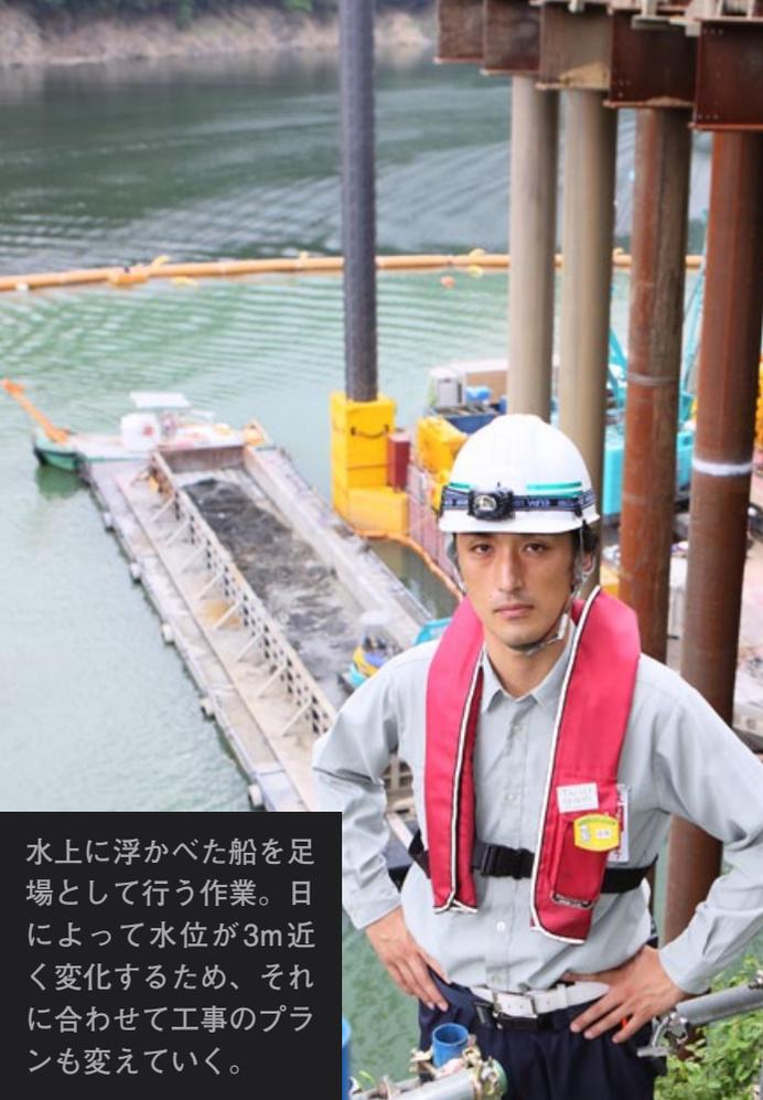
水面上に浮かべた船を足場として行う作業。日によって水位が3m近く変化するため、それに合わせて工事のプランも変えていく。
