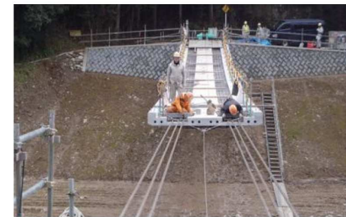
吊床版橋(施工例)
