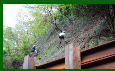
既存の落石防護ネットを撤去作業
