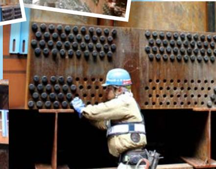
8つに分割した部材を連結板とボルトで一体化させて、1段の円環支保工が完成します。
