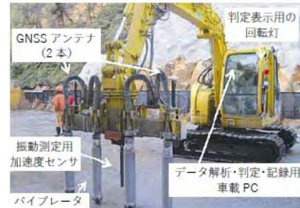
ダム用コンクリート締固め判定機の採用
