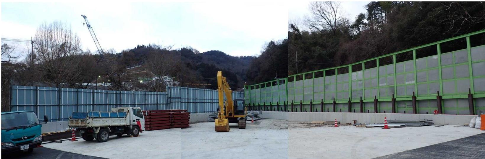
掘削岩石仮置場(遮水構造)及び仮囲い(防じん・防音構造)
