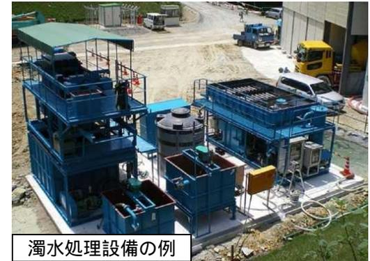
仮置きピットでは、地下浸透対策として搬路のアスファルト舗装、排水路及びアスカーブ設置、濁水処理設備設置及びモニタリングのほか、飛散防止対策としてピット内でシート養生を行う。
