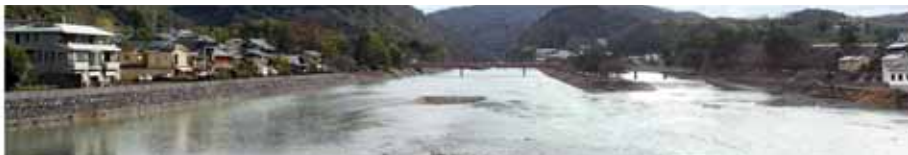
現況河道[平常時流量(約90m 3 /S)]
