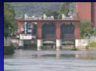
宇治発電所取水口
