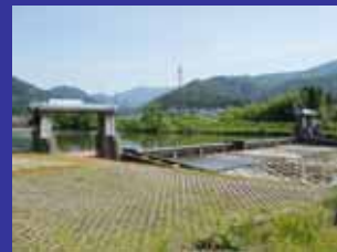
写真・高時川頭首工 (H15.6.3)
