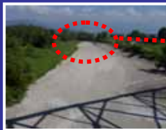
H15.10.9 瀬切れ発生(錦織橋上流)
