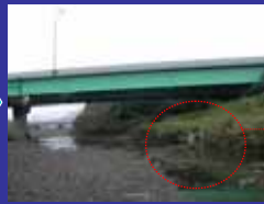
JR北陸本線直下の床固め工H15.11.12 河川流量減少により遡上が容易でない。
