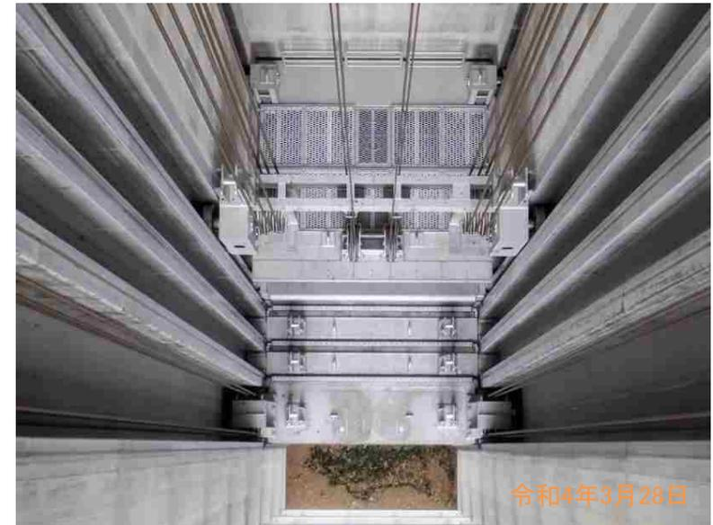
選択取水設備ゲート設置状況(取水塔内)
