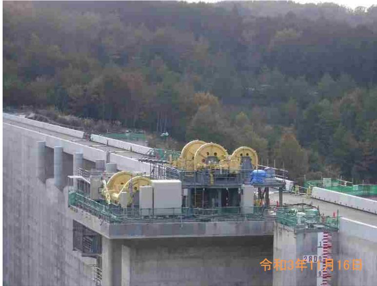
選択取水設備ゲート巻上機据付状況
