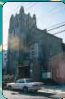
川口キリスト教会 明治6年に創建、大正4年に再建されたレンガづくりの建物です。
