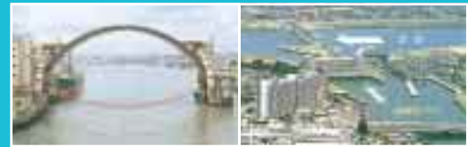
安治川水門 毛馬排水機場 (赤色は水門閉鎖時を示します)
