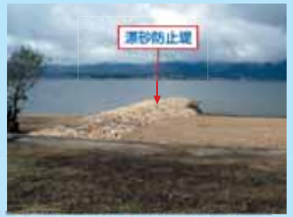
遊覧に配慮して石張りを施した吉川地区漂砂防止堤
