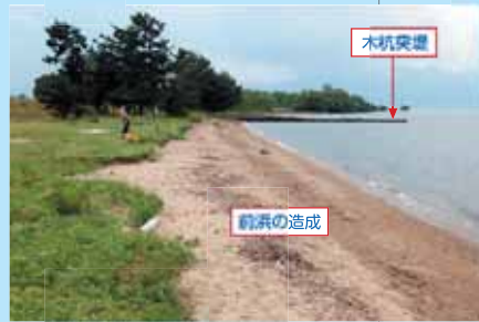
日野川河口右岸の現状(木杭突堤突堤工)
