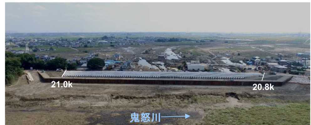
応急復旧完了後の状況(9/27)
