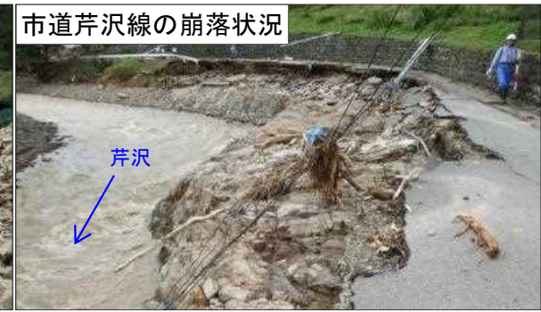
負傷者2名、家屋全壊5戸、半壊2戸 市道芹沢線が分断 住民25名が一時孤立
