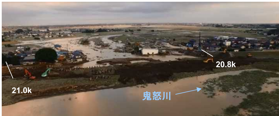
応急復旧状況(9/12)
