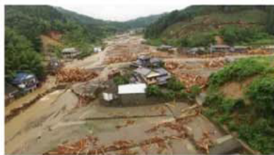
赤谷川における土砂・流木被害
