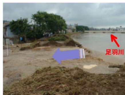
【九頭竜川水系足羽川の破堤状況 (福井県福井市)】
