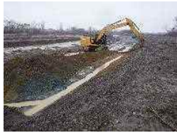
河道掘削 (石狩川水系、北海道開発局)
