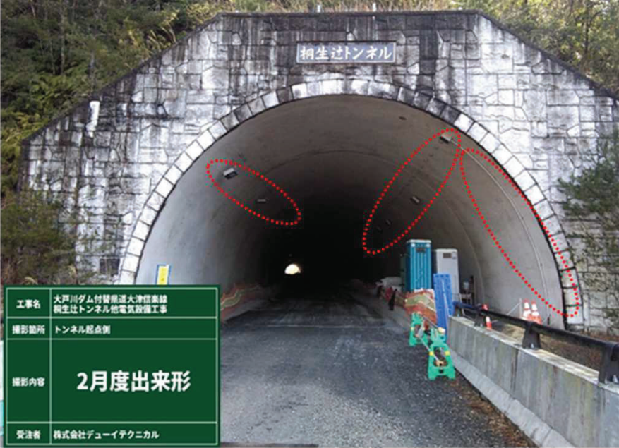
桐生辻トンネル
