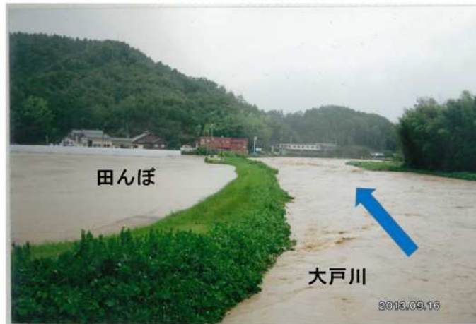
図 3 平成 25 年台風 18 号による被害状況
